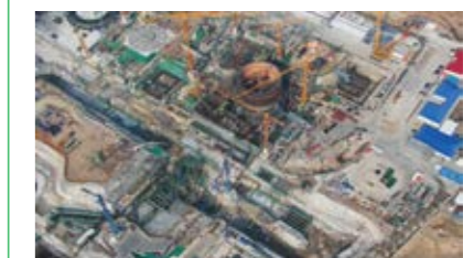
浙江三澳核电项目建设现场
