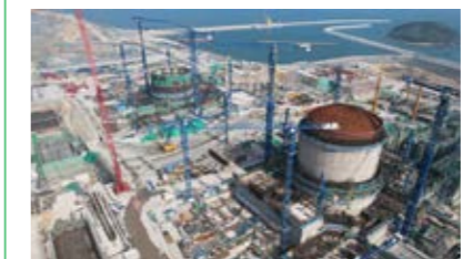
广东太平岭核电项目建设现场
