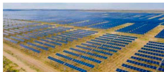
中广核内蒙古库布其沙漠光伏项目
