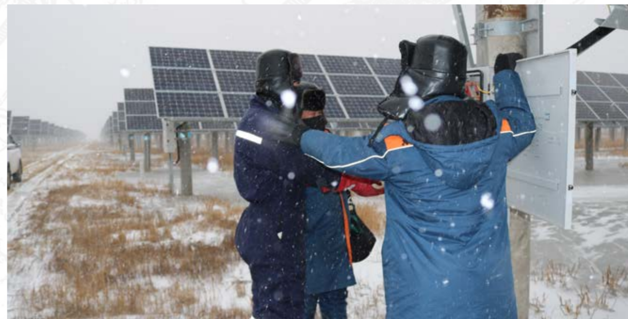
→ 在吉林自兴光伏电站，员工冒着雪对光伏场区设备开展特殊巡视，检查组件支架紧固程度，确保设备正常运行
